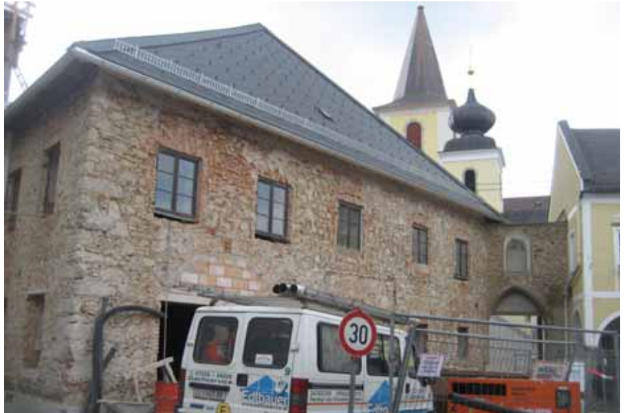
Der Umbau des Meindl-Hauses am Marktplatz Sarleinsbach als Beispiel für historisches Bauen.
